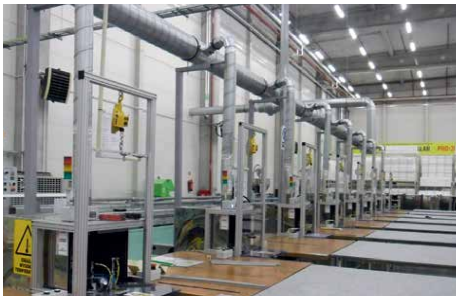
Zabezpieczenia stanowisk do produkcji uszczelek.
