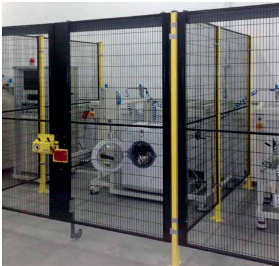
System osłon stałych i ruchomych blokujących z ryglowaniem, nadzorujących dostęp do stanowisk testowania pralek.
